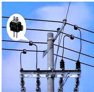
低压绝缘进户电线T接
